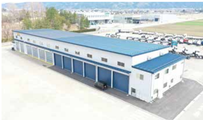
山島工場の外観
